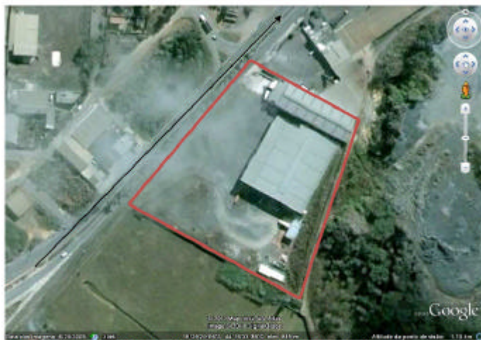
Figura 1 - Imagem Google – Detalhe do galpão do empreendimento
