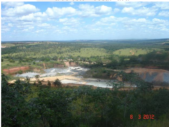
Vista geral do empreendimento – a partir da pilha de estéril em uso
