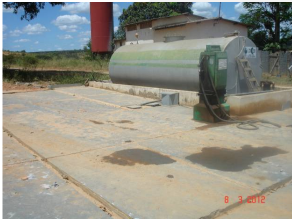
Tanque e pátio de abastecimento
