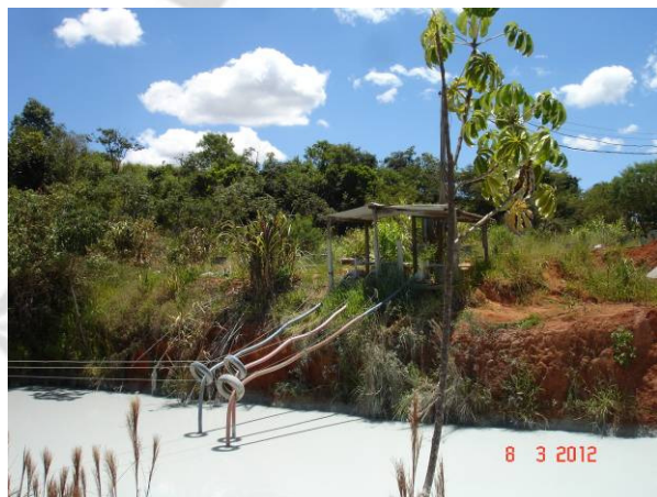
Foto 08 - Captação para recirculação da água
