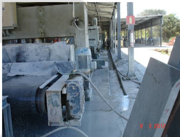
Foto 02 - Galpão de beneficiamento – canaletas de coleta de água servida
