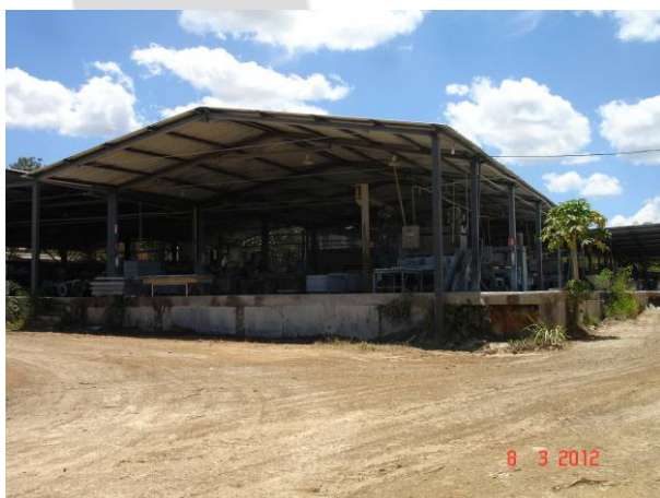
Foto 03 - Vista externa da área do galpão
