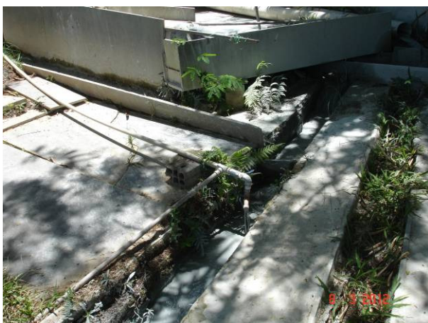
Foto 05 - Início o sistema de tratamento – adição de floculante/coagulante
