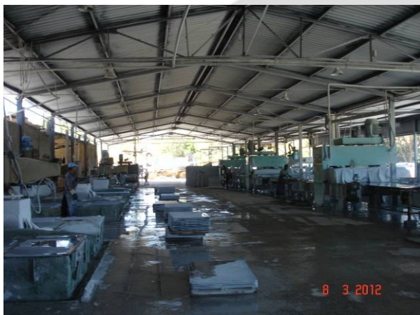
Foto 01 - Galpão de beneficiamento – vista geral
