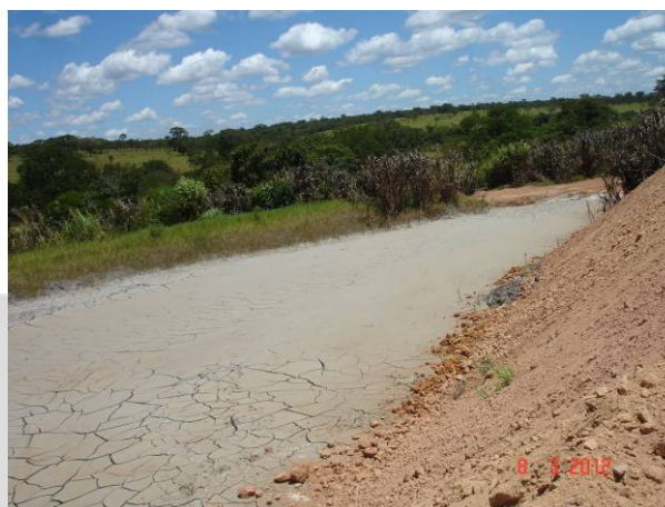
Foto 06 - Tanque de secagem
