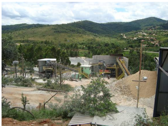
Foto 07. UTM com anteparos para atenuação de ruídos.
