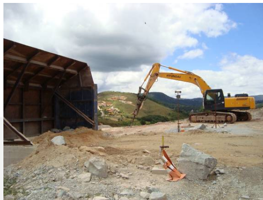
Foto 08. Continuação da foto anterior e rompedor hidráulico usado no desmonte secundário.
