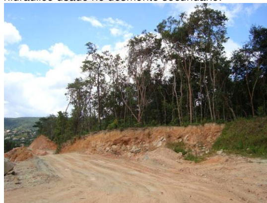
Foto 10. Vista da área do avanço de lavra onde ocorrerá a supressão de vegetação.
