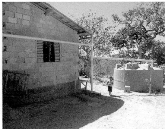
Foto 17. Caixa de captação de água pluvial
