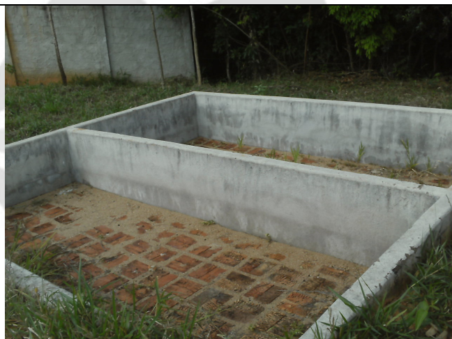
Foto 10: Leitos de secagem
