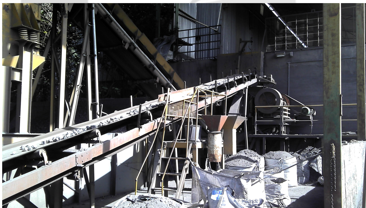
Foto 03: Setor de britagem 02
