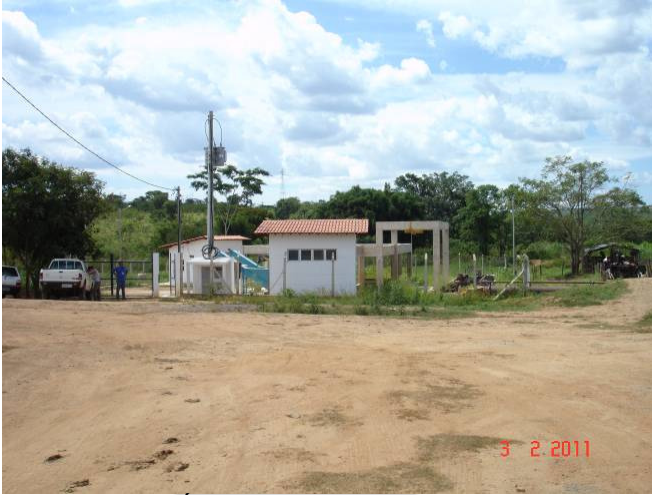
Foto 01- Área da Estação Elevatória Final e tratamento preliminar
