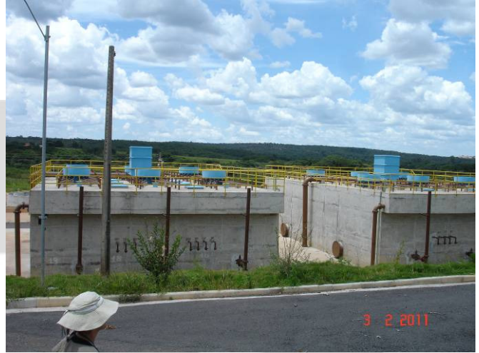
Foto 02 - Reatores UASB
