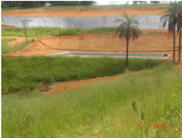
Foto 1 - Vista geral da área do aterro e tanque de recebimento do percolato
