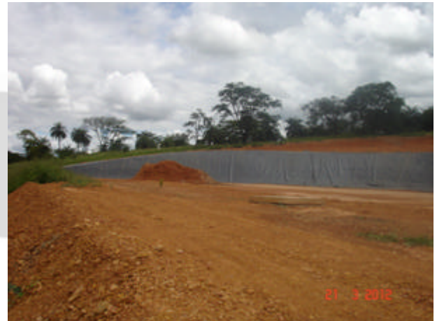
Foto 2 - Vista geral da área do aterro, taludes impermeabilizados.
