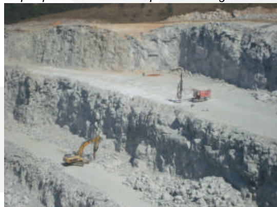
Foto 12. Rompedor hidráulico (equipamento amarelo) utilizado no desmorte secundário.
