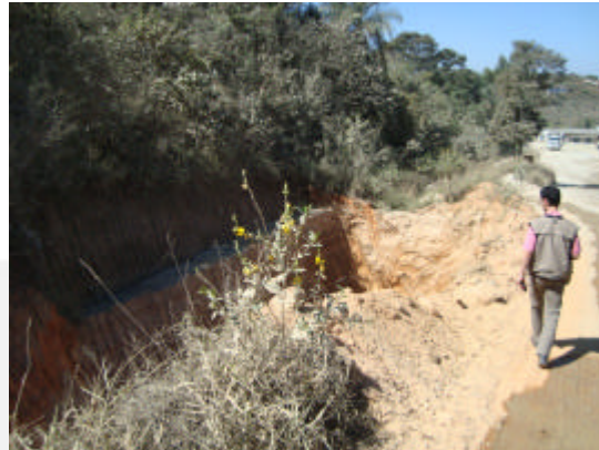
Foto 08. Sistema de contenção de sedimentos de via interna.
