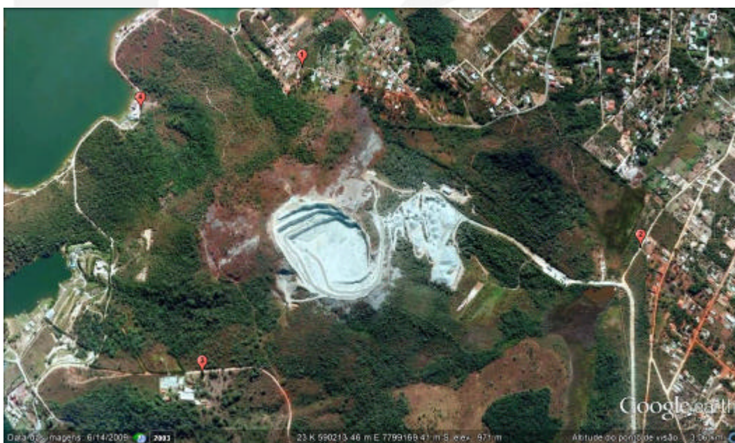
Imagem 02. Detalhe da Imagem 01 com pontos de monitoramento P1 a P4.
