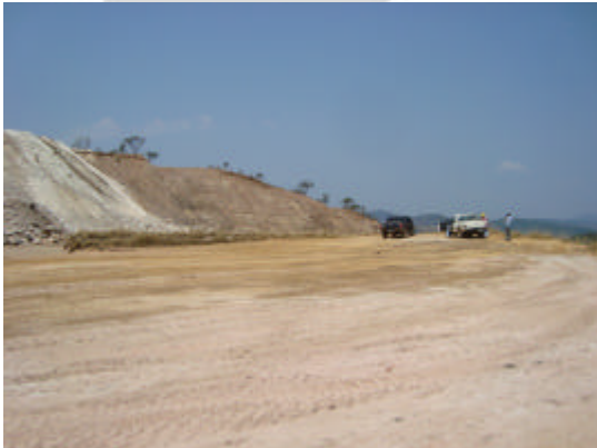
Foto 05. Reabilitação do Corpo 06 através da prática do “bota-dentro” (aterro).
