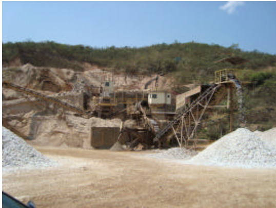
Foto 09. Vista da UTM
