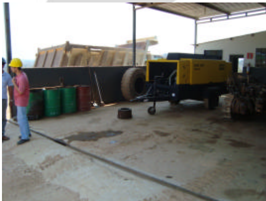
Foto 11. Oficina com piso impermeabilizado e canaletas de drenagem.
