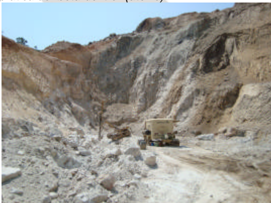
Foto 07. Perfuração do maciço quartzoso no Corpo 04 para uso de explosivos.
