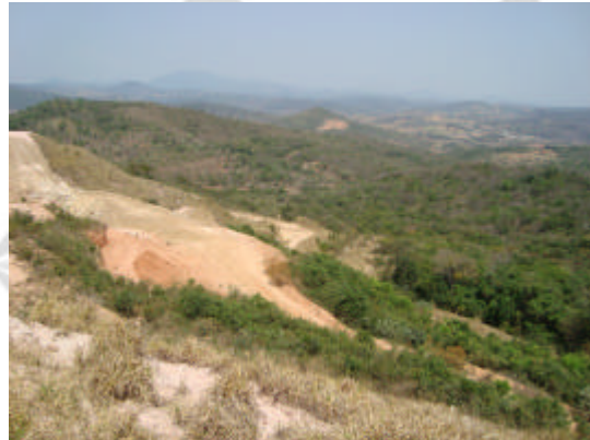
Foto 06. Base da pilha de estéril (Corpo 06) com sistema de contenção de finos a jusante.
