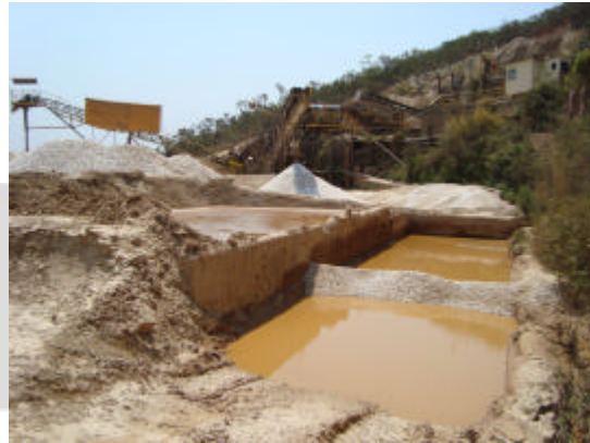
Foto 10. Sistema de recirculação de água utilizada na UTM.
