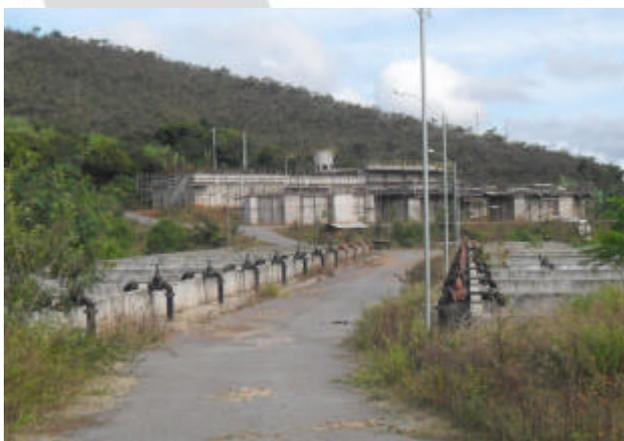
*Foto 1 – vista geral da ETE – obra paralisada: Leitos de secagem, filtros biológicos percoladores, decantadores secundários e reatores UASB.*
