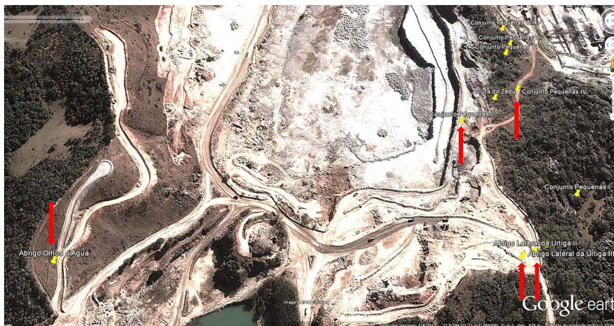
Figura 3 – Detalhe do setor onde, aparentemente, foram suprimidas algumas cavidades naturais subterrâneas (setas vermelhas) localizadas no empreendimento Mineração Belocal Ltda, em Matozinhos. Fonte: Google Earth; CECAV, 2012.
