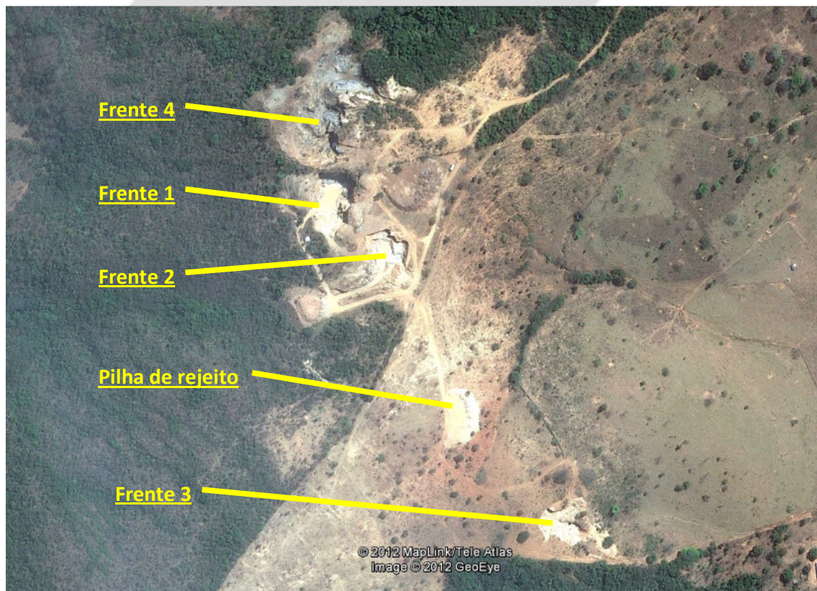
Figura 01. Visão geral do empreendimento, localizado no distrito de Fidalgo, município de Pedro Leopoldo. Fonte: Google Earth.
