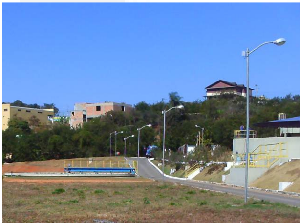
Foto 3 – Decantador secundário (esquerda) filtro biológico (direita)
