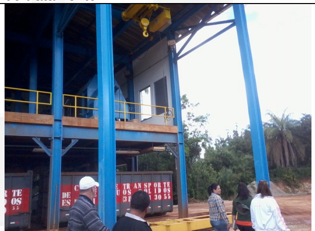
F11 – UTR desidratação do lodo
