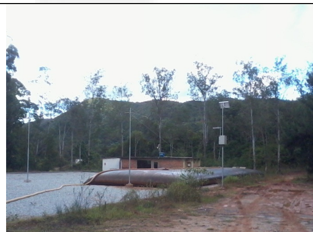
F10- Unidade de tratamento dos resíduos (UTR) , bags de desidratação
