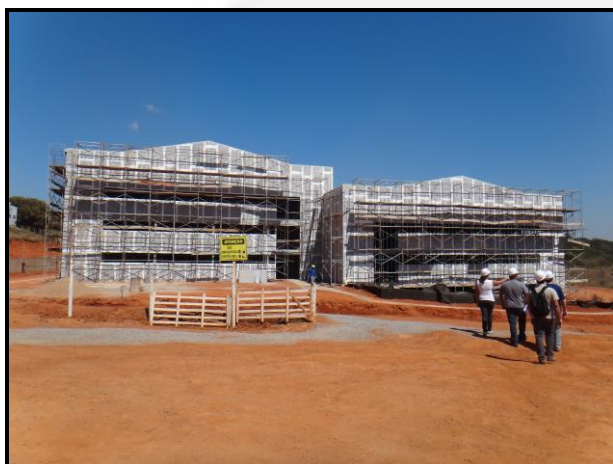
Foto 01. Vista da instalação do 1º galpão
