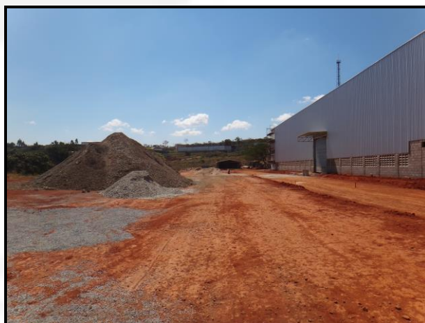
Foto 02. Vista da terraplanagem em execução
