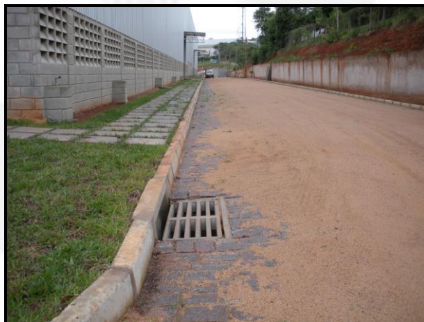
Foto 04. Vista da drenagem executada em função do TAC
