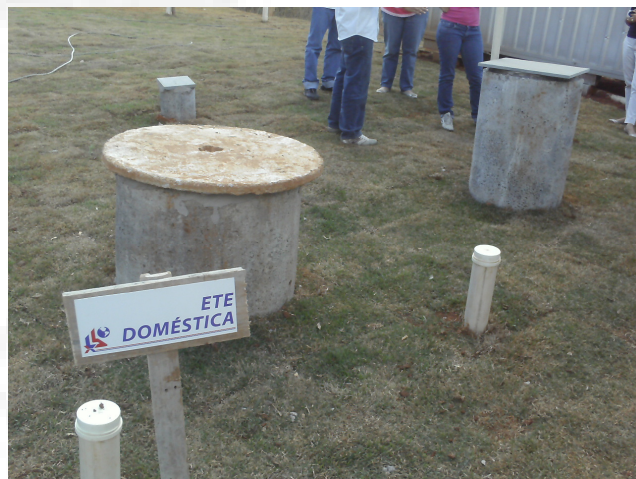
Foto 02. ETE para o efluente sanitário.
