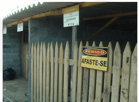
Foto 4. Baías do depósito de resíduos temporários.
