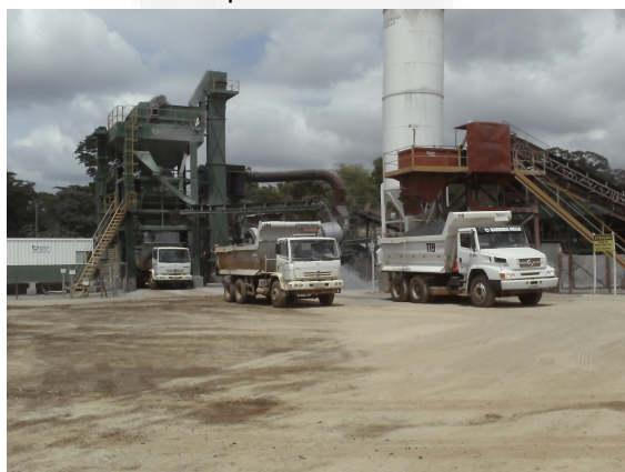
Foto 3. Pátio de abastecimento dos caminhões com concreto asfáltico usinado.
