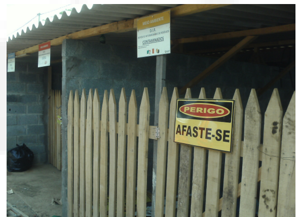
Foto 4. Baías do depósito de resíduos temporários.
