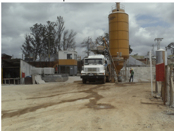
Foto 3. Pátio de abastecimento dos caminhões com concreto comum usinado.
