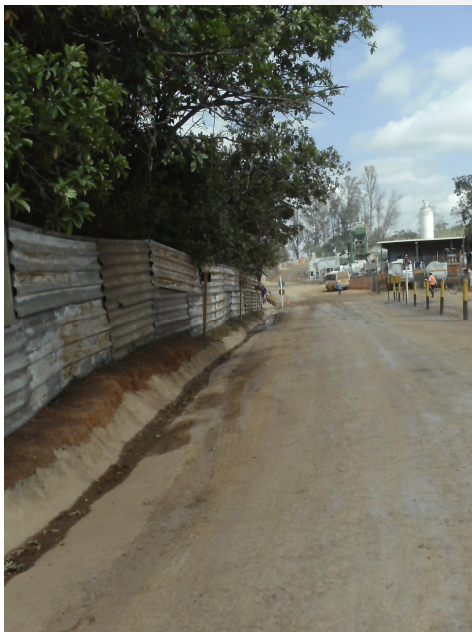
Foto 1. Canaleta de drenagem pluvial e tapumes fixados para contenção de particulados.
