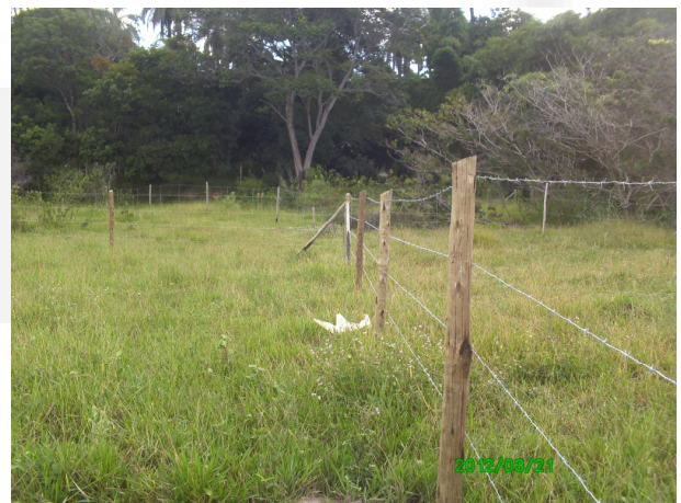
Foto 04 – Cercamento das áreas.
