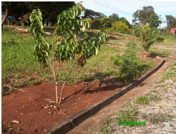
Foto 01- Limpeza das canaletas.
