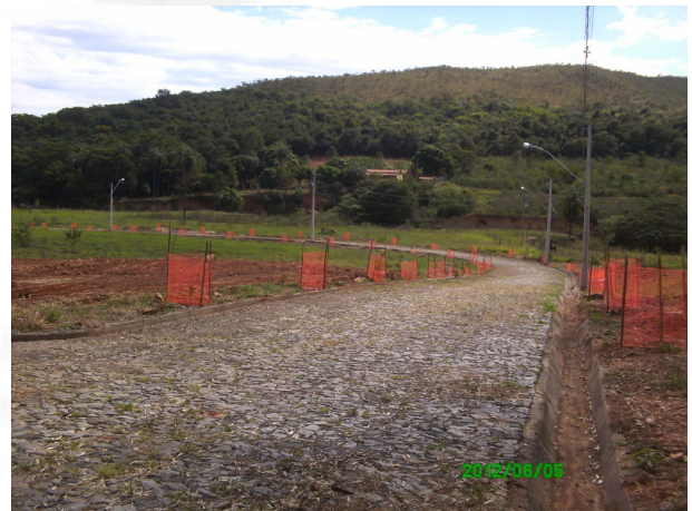
Foto 02 – Plantio da arborização viária.
