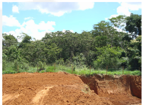
Foto 06. Vista da APP do córrego Jequitibá cercada e bacia de contenção de sedimentos.
