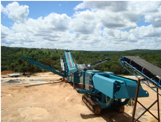
Foto 01. Vista da planta móvel (parte da UBM) fixada no local.
