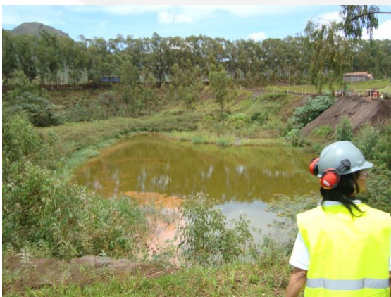
Foto 05. Dique de contenção de finos do sistema de drenagem fluvial do terminal.
