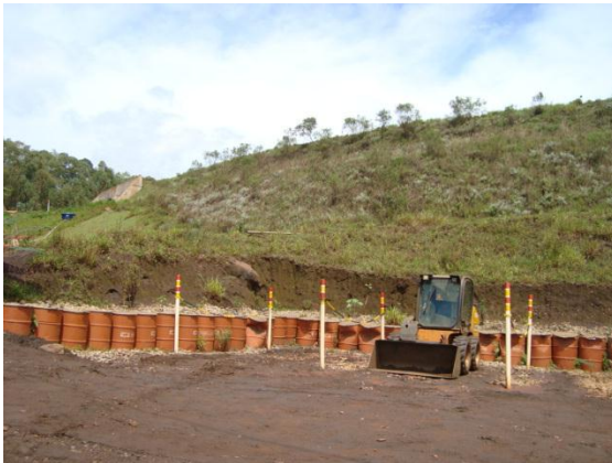
Foto 01. Talude externo ao pátio do terminal revegetado.
