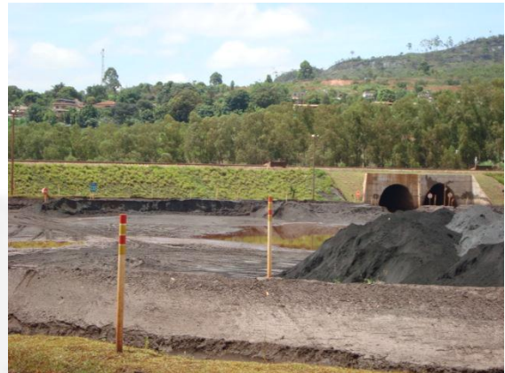
Foto 02. Talude interno ao pátio do terminal revegetado e leira para drenagem de água fluvial (1º plano).
