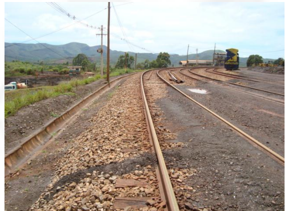
Foto 04. Vista da espiral ferroviária, sistema de drenagem e máquina de manobra de vagões da NAMISA.
