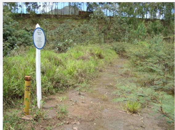
Foto 06. Berma do talude superior do dique com medidor de Nível de Água.
