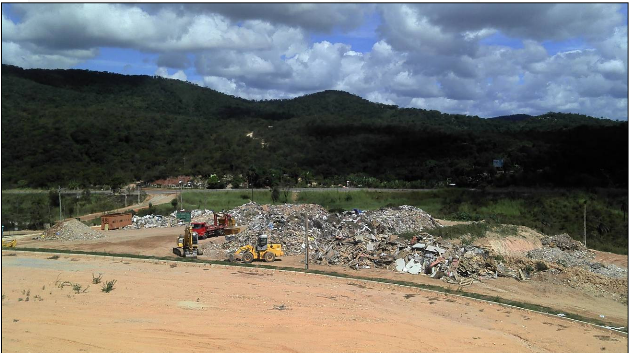
Foto 03: Vista da Área de Transbordo e Triagem de Resíduos de Construção Civil – RCC, aonde será instalada a usina de reciclagem de RCC.
