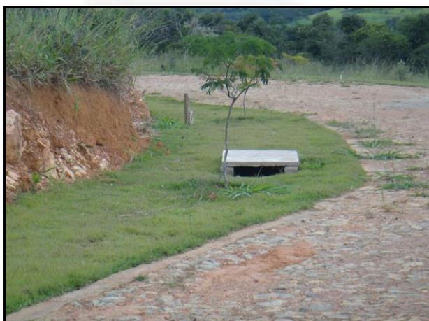
**Foto 03.** Detalhe do sistema de drenagem
