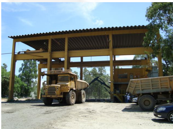
Foto 05. Fora de estrada descarregando minério no alimentador da britagem da mina com rompedor hidráulico (2º plano).
