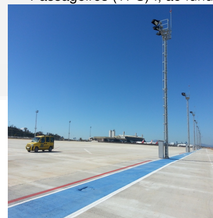
Foto 4. Sinalização horizontal e vertical.
