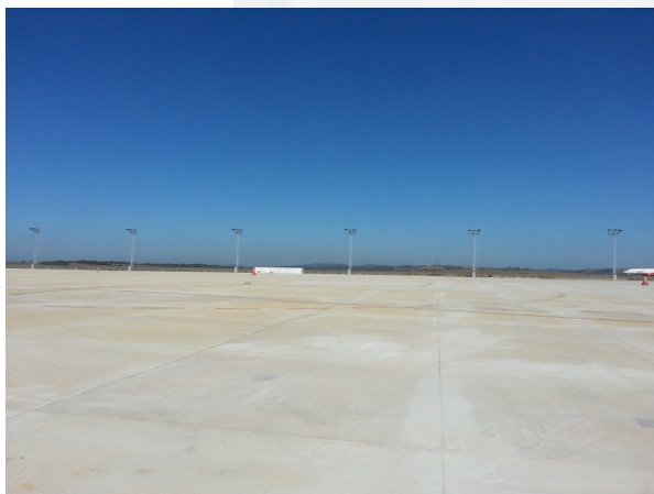
Foto 3. Sinalização/iluminação já instaladas.
