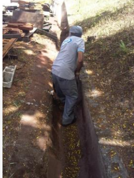
Figura 1: Limpeza das canaletas de drenagem pluvial.
