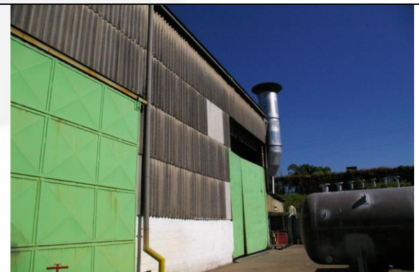
Figura 6: Vista da chaminé da cabine de pintura.
