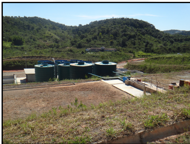
Foto 03 – Vista geral da ETE
