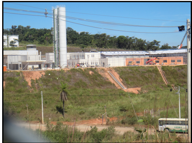
Foto 02 – Vista externa da Unidade Semiaberto
