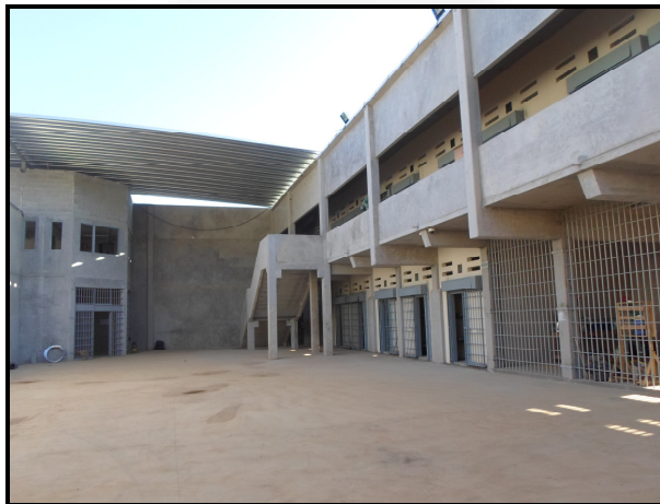
Foto 01 – Foto interna da área de celas
