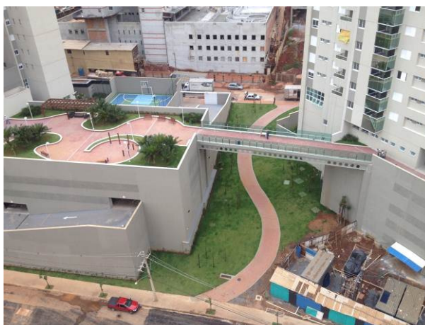
Foto 03 – Passarela sobre faixa de drenagem.
