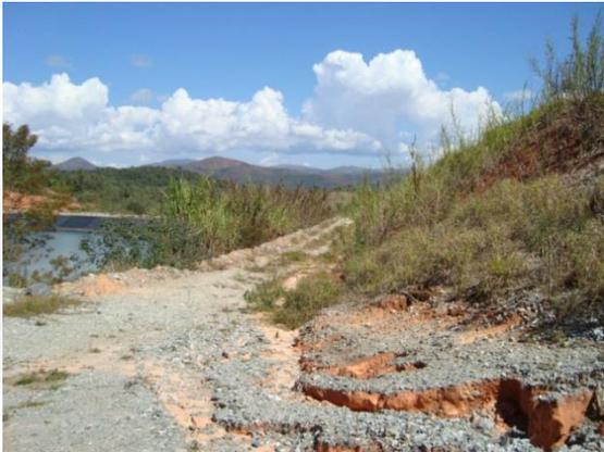
**Foto 21.** Berma (via) entre a BI e BII, com erosão.
