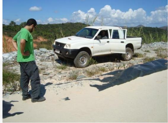
**Foto 14.** Ponto da BI sem borda livre com início de extravasamento de material do lago assoreado.
