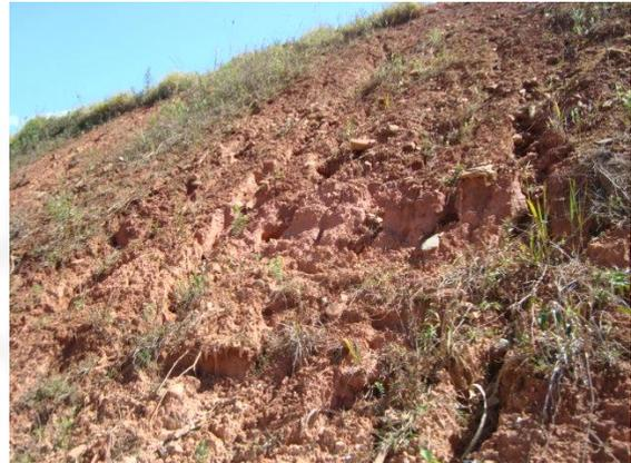
**Foto 22.** Talude de jusante da BI com ravinamento/erosão.
