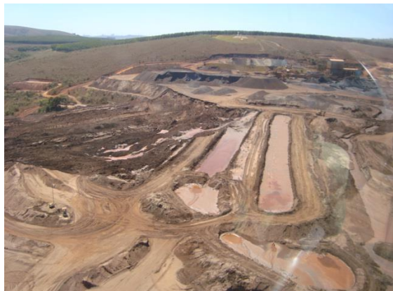
Foto 01. Vista do local de rompimento e baias restantes utilizadas na B1.
