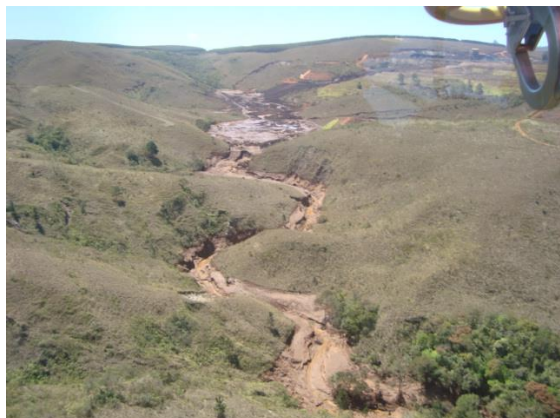
Foto 07. Curso d'água a jusante da B3, afetado pelo rompimento da B1.
