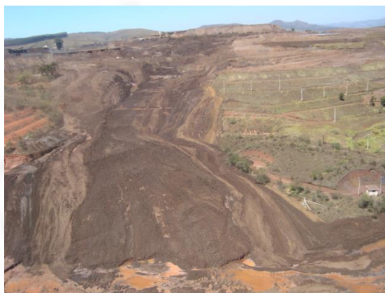
Foto 04. Vista de frente do movimento de massa proveniente do colapso da B1.
