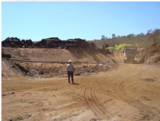
Foto 15. Obras emergenciais da B3 para contenção de eventual movimentação da B1 e material (escuro) que galgou o corpo.
