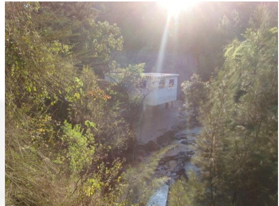
Foto 14. Ponto de captação do condomínio Vila Bela no curso d'água afetado.
