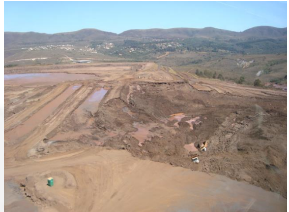
Foto 02. Idem foto anterior de ângulo oposto com detalhe de dois caminhões soterrados.
