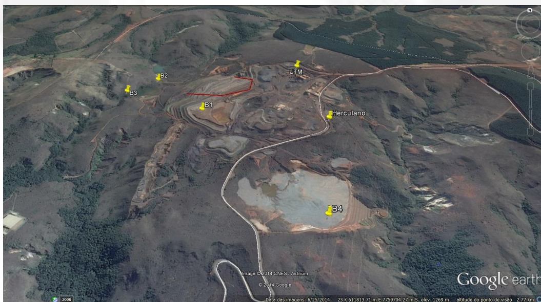
Imagem 02. Detalhe da imagem anterior demonstrando as estruturas (barragens B1, B2, B3, B4 e beneficiamento) do empreendimento, vale do afluente do córrego do Silva e local do rompimento da barragem B1 (linha em vermelho).
