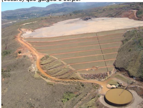
Foto 17. Vista da dos taludes de jusante e lago de deposição de rejeitos da barragem B4.
