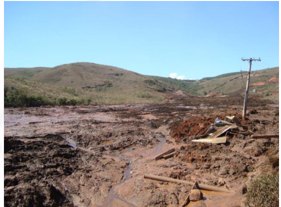
Foto 10. Impacto sob o vale do afluente do córrego do Silva, afetado pelo rompimento, a montante da B3.
