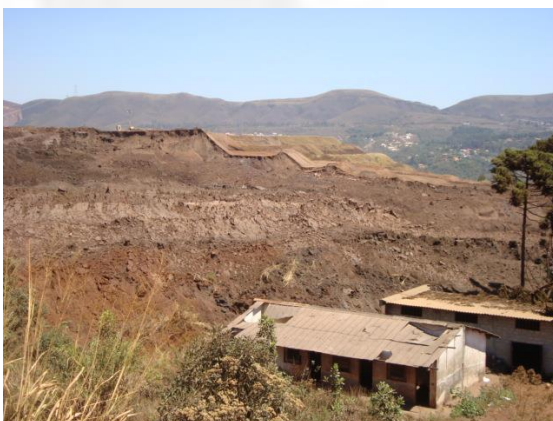
Foto 11. Vista em seção dos taludes de jusante da B1 onde houve o rompimento.
