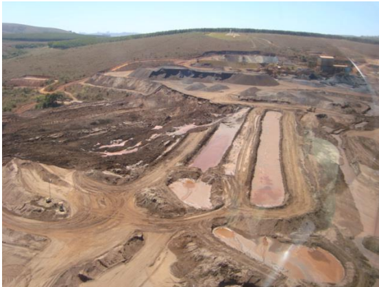
Foto 01. Vista do local de rompimento e baias restantes utilizadas no lago de deposição da B1.
