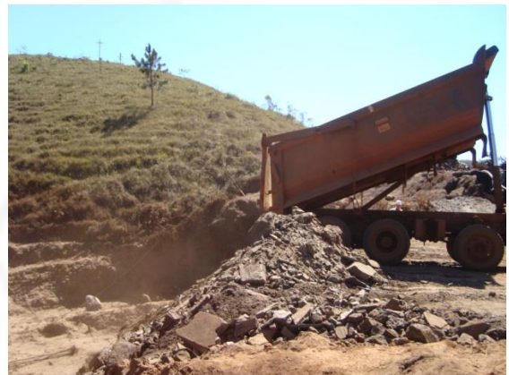
Foto 16. Obras emergenciais de reforço do talude de jusante remanescente da B3.
