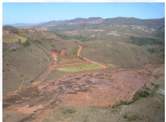
Foto 06. Vista do material proveniente do rompimento da B1 contido no vale a jusante da B3.
