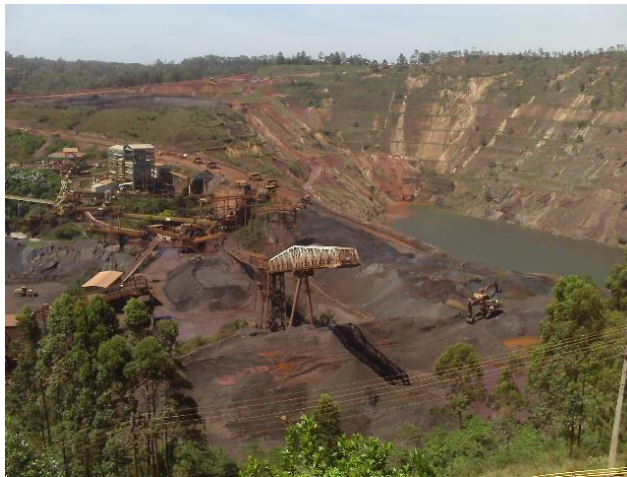
Foto 01. Edificação da UTMS, à esquerda, e cava da Mutuca, à direita.
