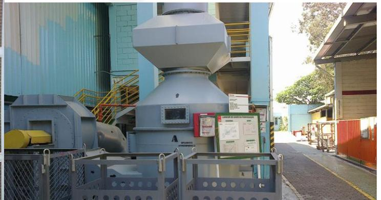
**Foto 2:** Lavador de gases da fosfatização
