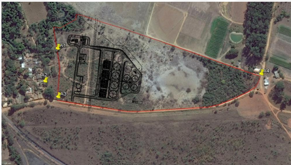
Figura 11 – Imagem de satélite com a localização dos pontos de monitoramento de ruído.
