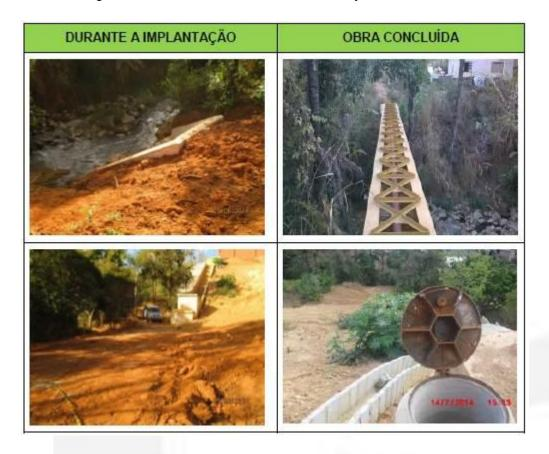
L3 - Lançamento de drenagem composto por escada hidráulica (600 mm de largura x 18 metros de comprimento) e muro de ala para tubulação de concreto de 600 mm. Área de intervenção em APP para instalação do sistema de lançamento de drenagem de 70,29 m², com execução de: cortes para instalação da escada hidráulica, e execução do muro de ala. Foi executada a conformação da terraplenagem.
