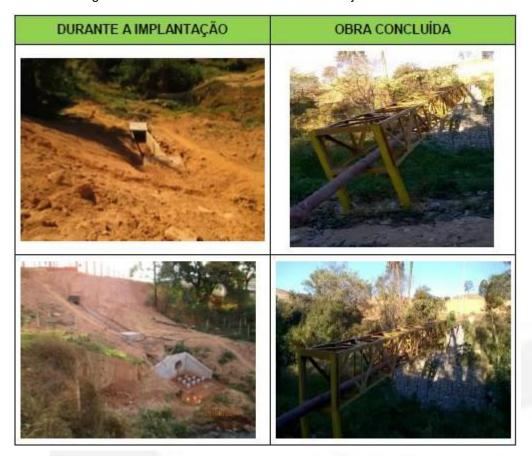
L5 - Lançamento de drenagem composto por tubulação de concreto (diâmetro nominal 800 mm - aproximadamente 30 metros de comprimento). Área de intervenção em APP para instalação do sistema de lançamento de drenagem de 371,44 m², com execução de: movimentação de terra para adequação do nível do terreno, e escavação para instalação da tubulação de concreto. Instalação do muro de ala para direcionamento do fluxo de água pluvial em execução e de dissipador de energia na laje do muro de ala.
