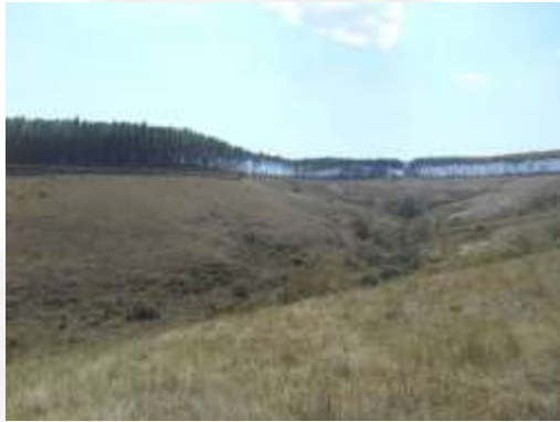
Porção sul da barragem, área com maior cota altimétrica
