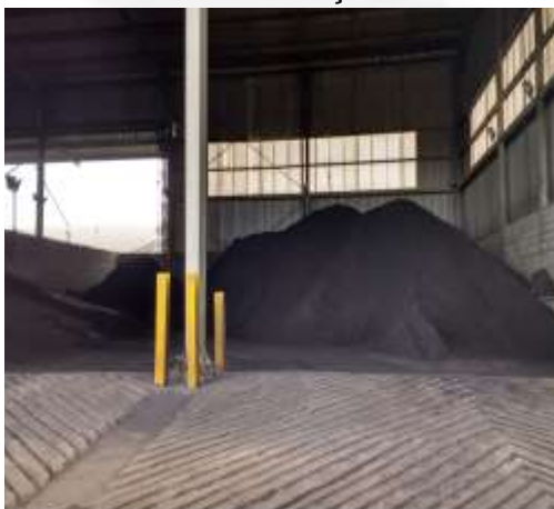
Foto 03. Limpador de pneus na entrada do galpão
