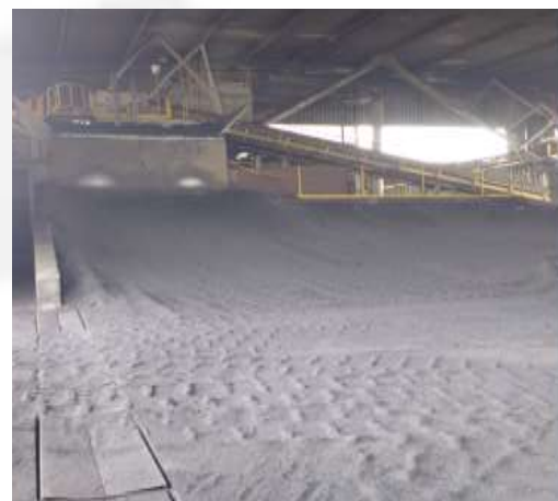
Foto 04. Rampa de alimentação da moega e canaletas na entrada do galpão
