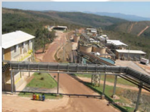
Foto 4 - Canalização da polpa de rejeito para utilizada no preenchimento da mina subterrânea.
