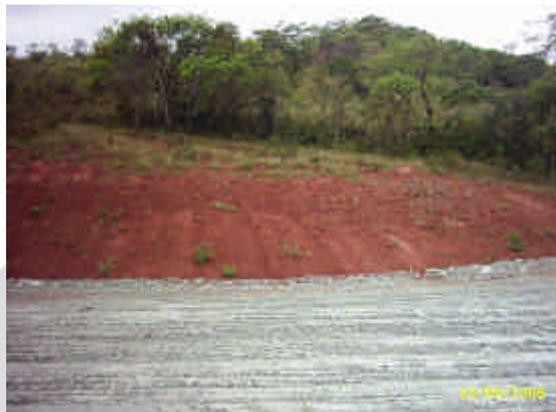
FIGURA V – Nível da segunda bancada existente na Pilha de Estéril Marzagão. A terceira berma atingirá o nível do talude desprovido de vegetação.
