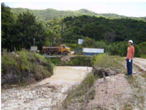
**Foto\_09.** Bacia de contenção de finos (assoreada) ligada ao sistema de drenagem pluvial da cava.
