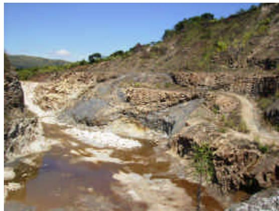
**Foto\_06.** Sistema de drenagem pluvial que direciona toda a água para bacia de contenção de finos.
