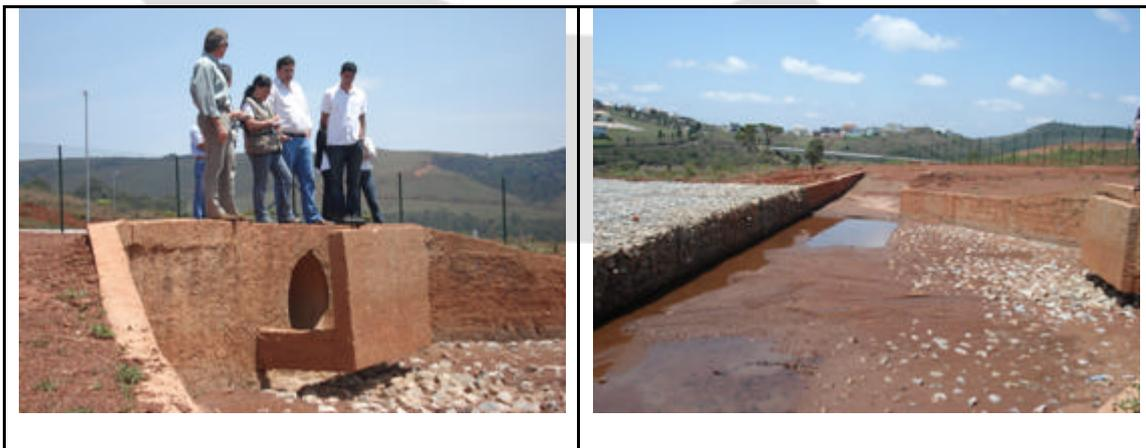
Fotos 3 e 4 – Filtro de retenção de finos provenientes do sistema de drenagem pluvial.
