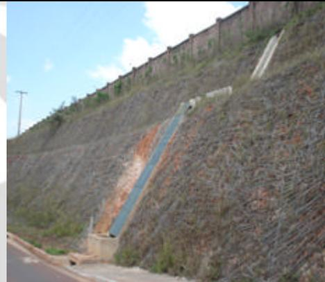
Foto 16 – Sistema de drenagem e contenção de talude às margens da BR 356
