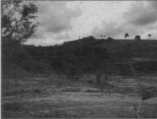
Foto 03. Vista da futura cava com decapeamento de parte da jazida realizado no passado.
