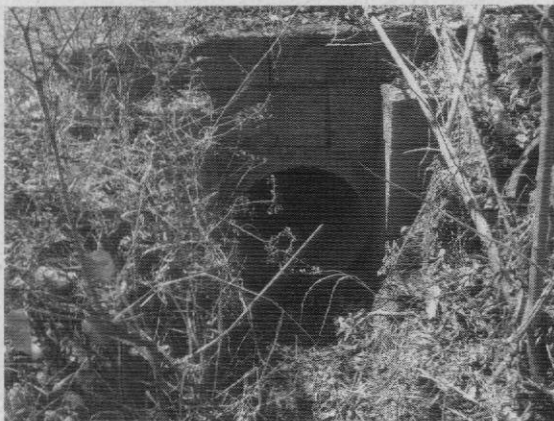
Foto 3: Manilha de concreto implantada sob a rua
