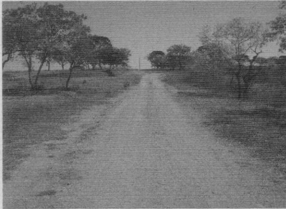
Foto 1: via de circulação sem pavimentação
