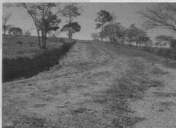
Foto 6 - Vias e taludes
