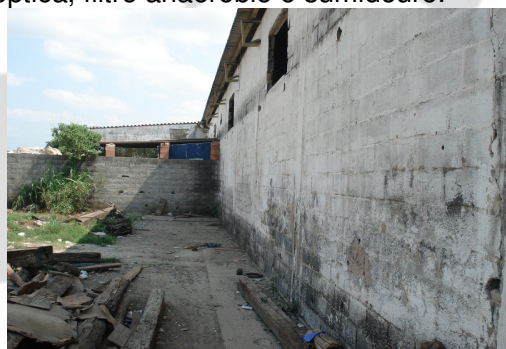
Vista externa do galpão
