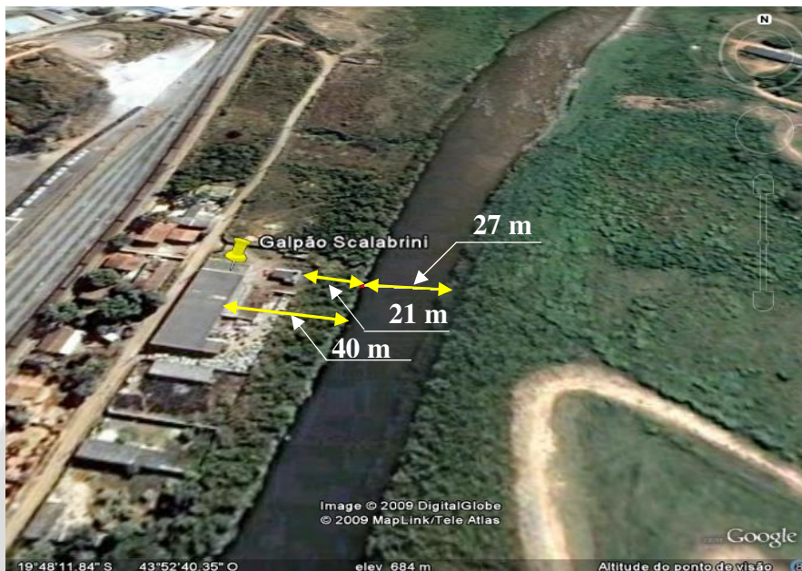
Vista aérea do galpão e o Rio das Velhas
