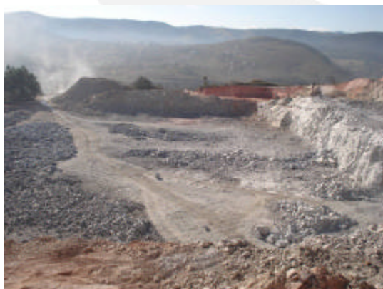
Foto 05. Vista da praça de trabalho do ponto onde será feito o avanço da frente.
