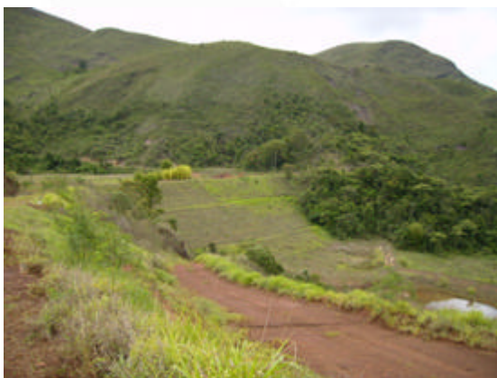
Figura 1: Alteamento da Barragem B5 Fonte: Vistoria em 28/11/2008
