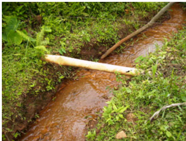
Figura 3: Tubulação danificada da rede de lançamento do empreendimento Fonte: Vistoria em 28/11/2008
