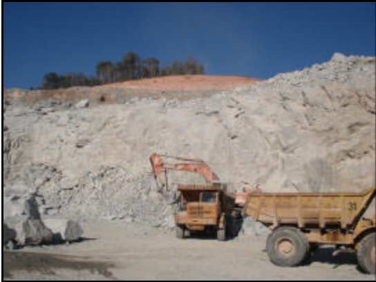
Foto 01. Vista do maciço rochoso onde será feito decapeamento e avanço da lavra e equipamentos.
