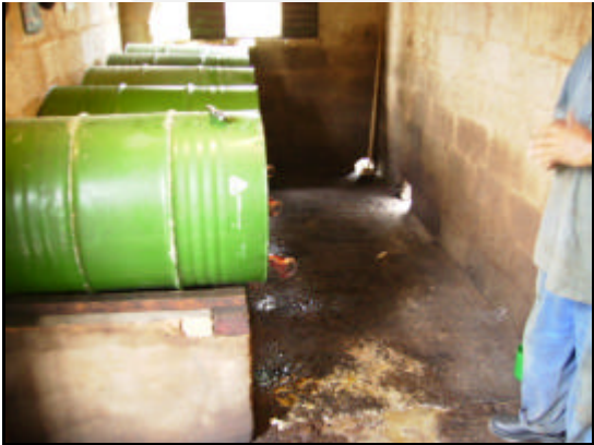
Foto 03. Local de armazenamento de óleo que deverá passar por obras de melhoria.
