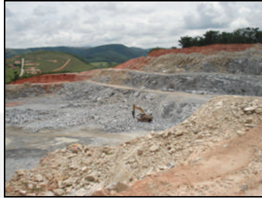
Foto 02. Vista das bancadas e equipamento de desmonte secundário (rompedor hidráulico)
