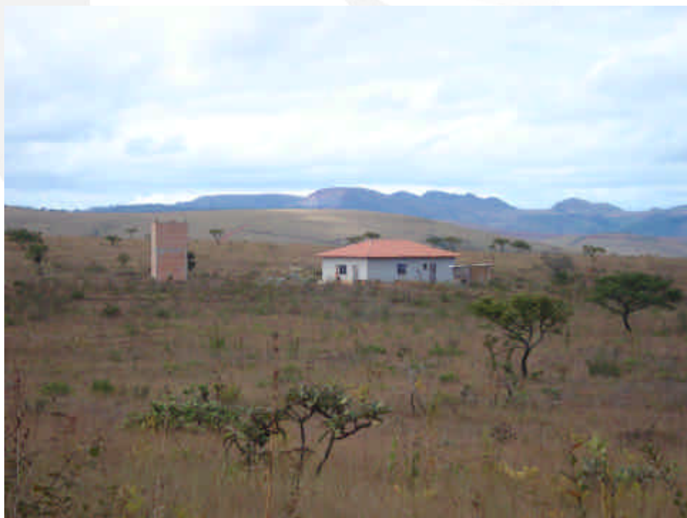
Figura 6: Edificação existente na área do empreendimento
